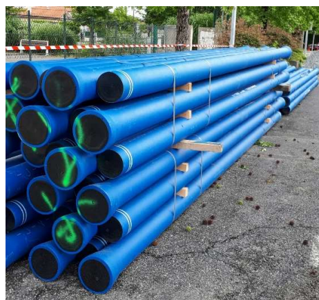
↑ Conduites en fonte de 150 mm avant pose à Billère.
