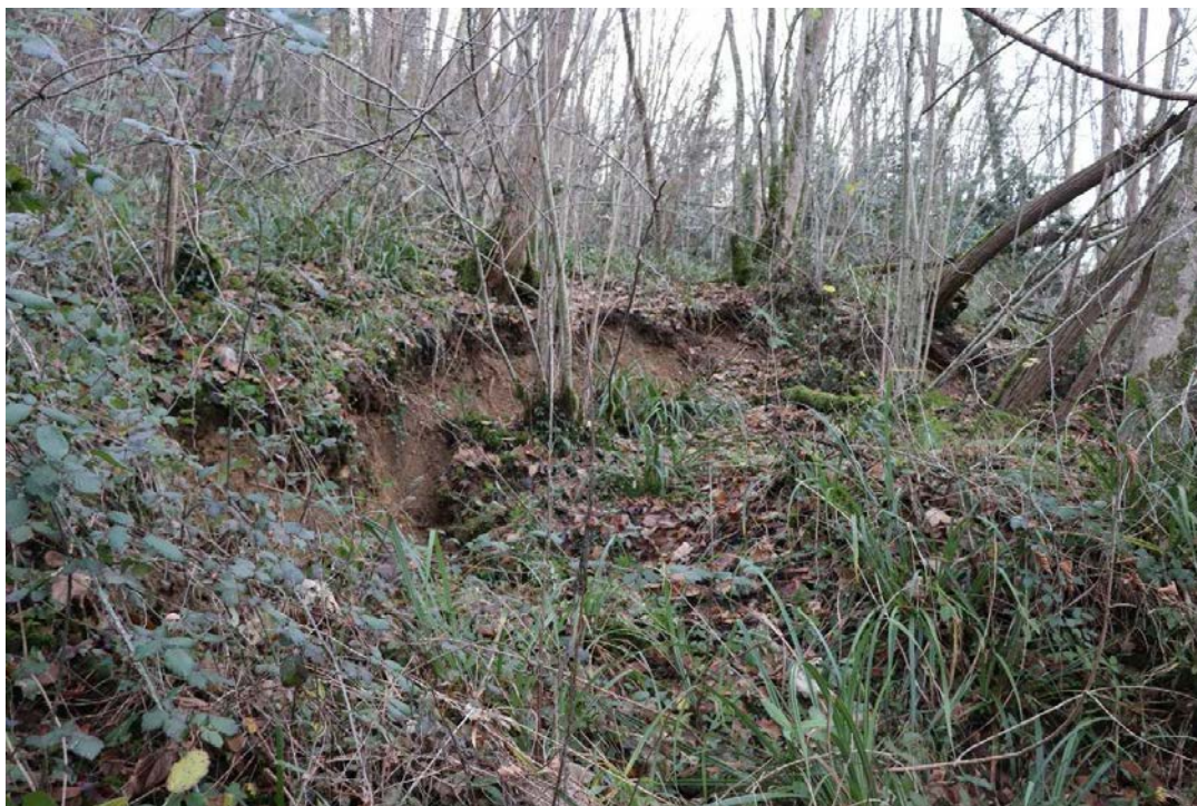
Figure 2 : terminaison « Sud-Est » de la courbe du glissement de terrain, à quelques mètres de la conduite en Acier.
