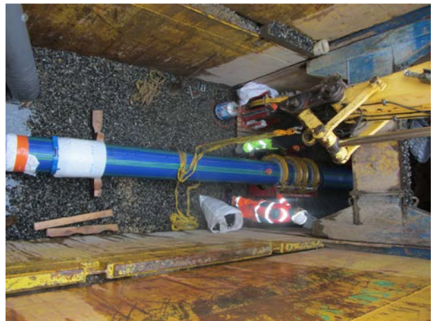
↑ Insertion tube PEHD sous voie-ferrée à Bizanos.
