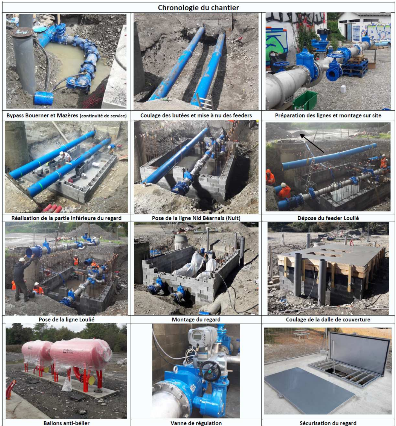
Fig. 2 : Chronologie des travaux réalisés en 2018 sur les réseaux de transit du Nid Béarnais et du Loulié (d'après HEA, maître d'œuvre).
