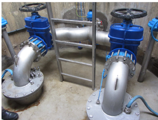
↑ plateforme intermédiaire et départs des 2 exhaures.
