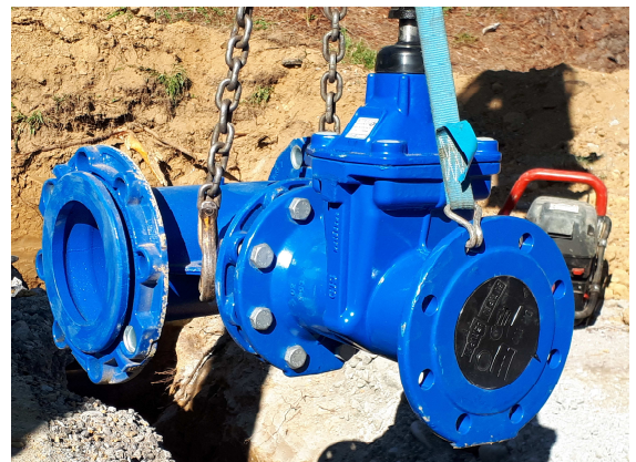
↑ Détail d'un té + vanne de 100 mm avant pose.
