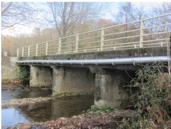
↑ Pose d'un PEHD 32 sous fourreau inox à Meillon.
