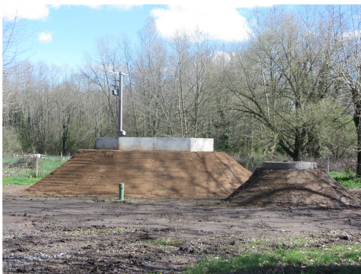
↑ Puits « P13 bis » (à gauche) et puits « P13 » avant ré-engazonnement du site et des tertres.
