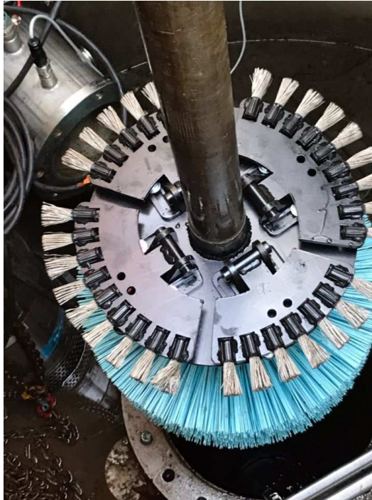
↑ outil de nettoyage et de brossage lors de l'intervention dans le Puits « P16.
