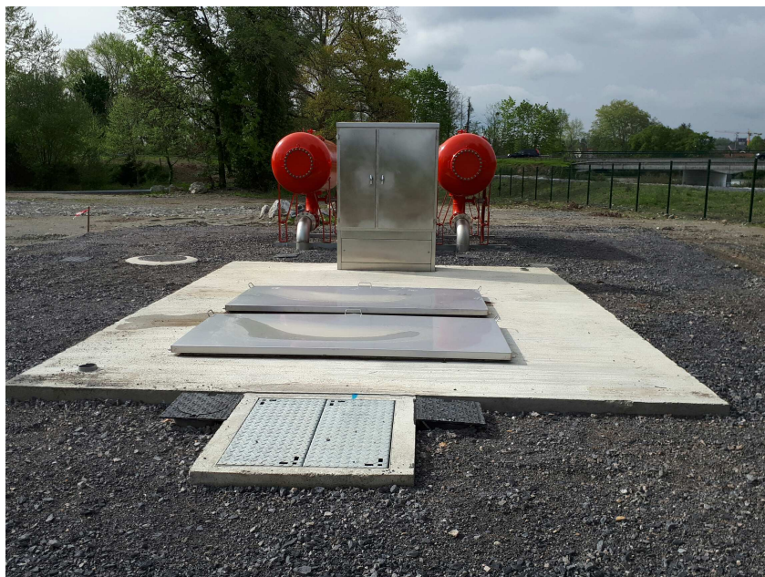
↑ Vue d'ensemble du regard enterré, de l'armoire de commande et des anti-béliers.
