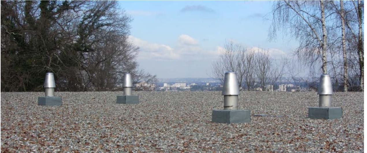
↑ Vue sur les 4 cheminées d'aération de la dalle de couverture isolée et recouverte de graviers roulés du « 3000 ».
