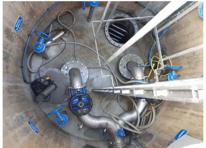
↑ plateforme intermédiaire et hydraulique en cours de pose.
