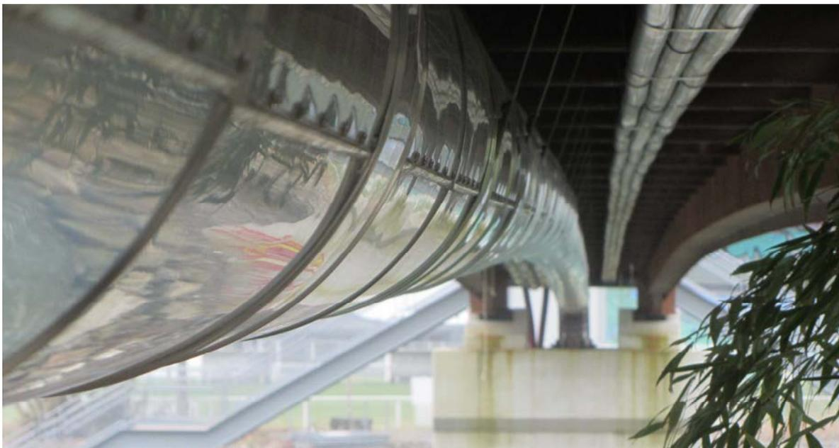
↑ Nouvelle conduite inox de 406 mm, isolée et capotée en aluminium sous la passerelle de Mazères-Bizanos.
