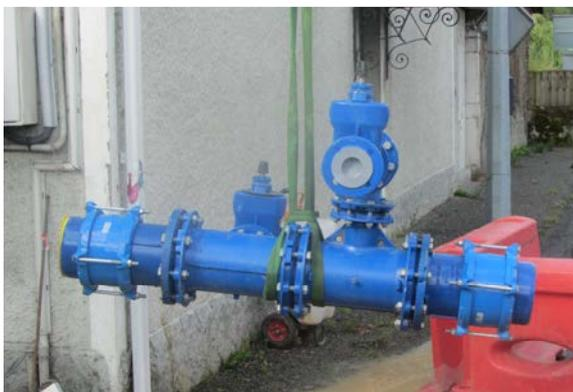
↑ Pose de té et vannes sur réseau fonte de 200 mm.
