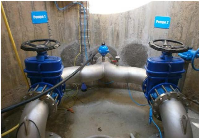
↑ Détail des 2 colonnes d'exhaure du puits en travaux.
