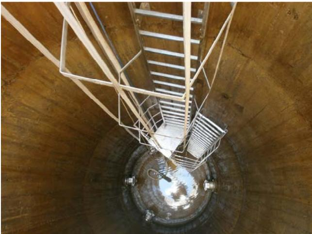
↑ Echelle à crinoline et vannes inox à la base du puits.
