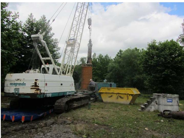
↑ Forage par havage méthode « BENOTO » avec louvoyeuse.
