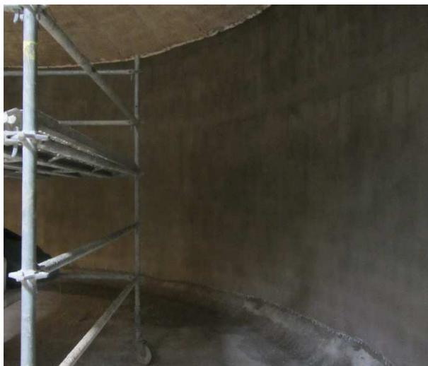
↑ Reprise du cuvelage intérieur (voile et radier) du réservoir semi-enterré (droit) de Batgusère.
