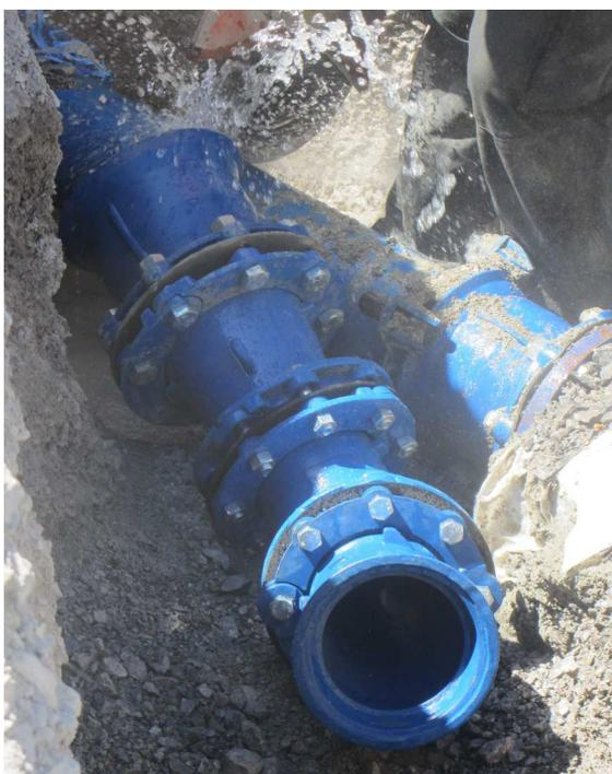
↑ Raccordement en cours d'une fonte 150 mm sur fonte existante de 125 mm.
