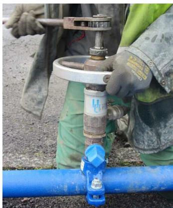
↑ Percement robinet de prise en charge sur Fonte 60 mm.
