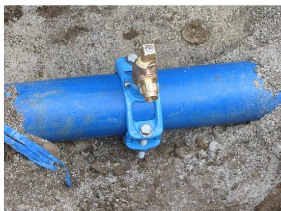
↑ Nouvelle conduite en fonte « ductile » de 60 mm (avec robinet de prise en charge verticale)
