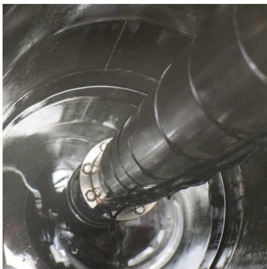
↑ Vue intérieure du puits avec colonne d'exhaure.
