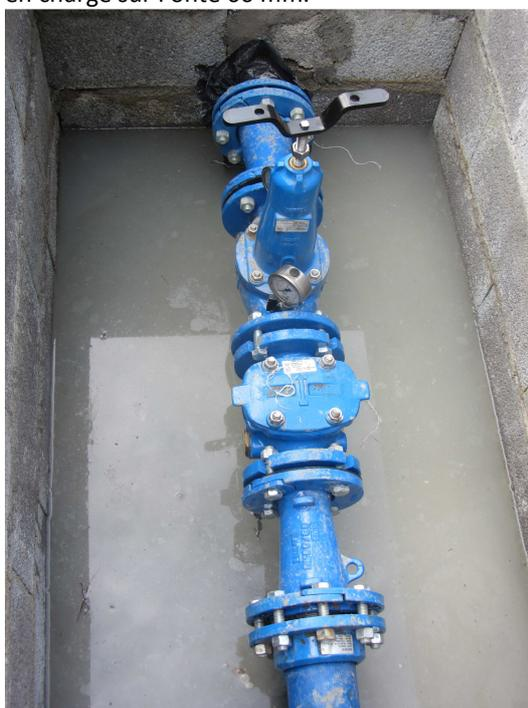
↑ Détail mono-stabilisateur avec boîte à crépine en DN 60/65 mm.
