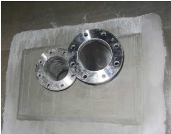
↑ Renouvellement de l'hydraulique en traversée de parois dans la bâche de la station de Lanot.
