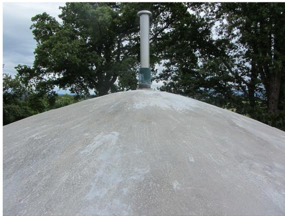
↑ Nouvelle coupole sur le dôme existant avant pose de l'isolant et de l'étanchéité sur la bâche de Lanot.
