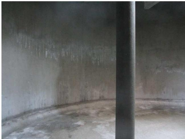
↑ Reprise intérieur de la cuve, du réservoir semi-enterré de Morlaàs-Haute Vue, au micro-mortier.
