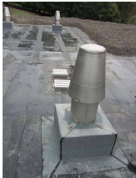
↑ Reprise cheminée d'aération et étanchéité extérieure avec isolant.
