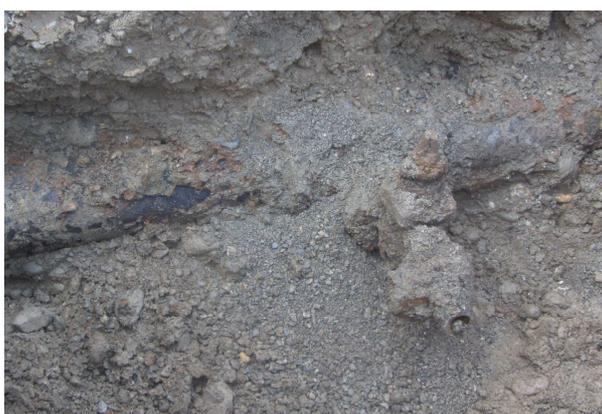
↑ Ancienne conduite en fonte « grise » de 1950 de 60 mm abandonnée (avec robinet de prise en charge latérale).
