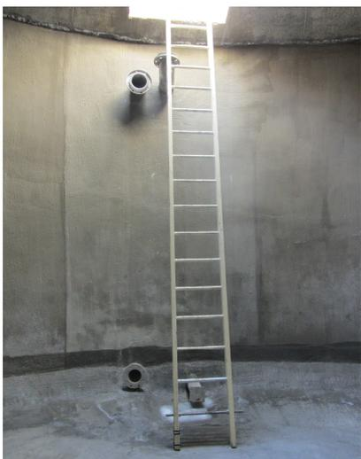
↑ Renouvellement de l'hydraulique en traversée de voile sur Batgusère.
