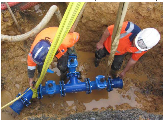
Assemblage d'un « té » et d'un jeu de vanne en 125/100 mm avant pose (Haute Vue, Morlaàs).
