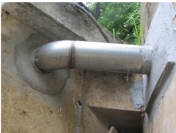
↑ Conduite inox de diamètre 200 mm d'alimentation du réservoir de droite, en cours de reprise.
