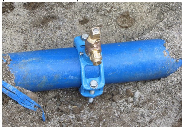
Détail d'une prise en charge de branchement sur conduite en fonte de 125 mm (Av. Henry IV, Jurançon).
