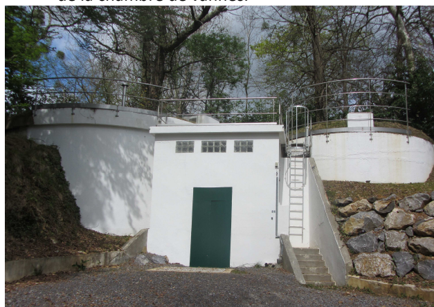
↑ Vue d'ensemble des réservoirs de Bastarrouse (GAN) après réhabilitation et sécurisation.
