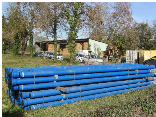
Bardage des tuyaux en fonte de 125 mm avant pose (Route du Pont à Assat).
