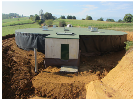
Fin d'étanchéité et des raccordements de la bâche (09/2013).
