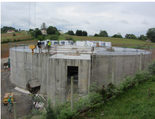
Réalisation chambre de vanne et pose des dalles de couverture (06/2013).
