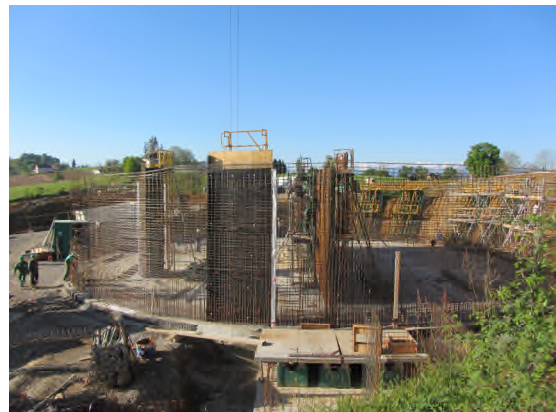
Ferrailage et coulage des voiles ou parois (05/2013).
