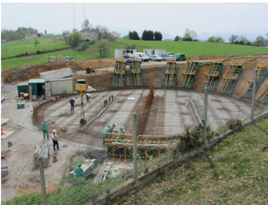
Ferrailage avant coulage du radier (04/2013).
