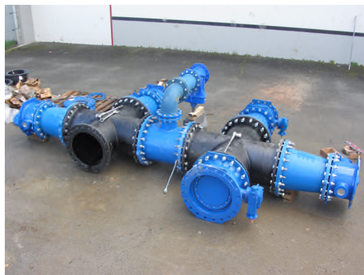
Agencement des croix, des vannes de sectionnement et des départs d'adduction en 500 ou 400 mm (12/2013).
