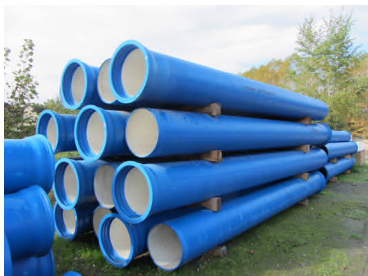
Entreposage sur site des tuyaux en fonte de diamètre 500 mm (automne 2013).
