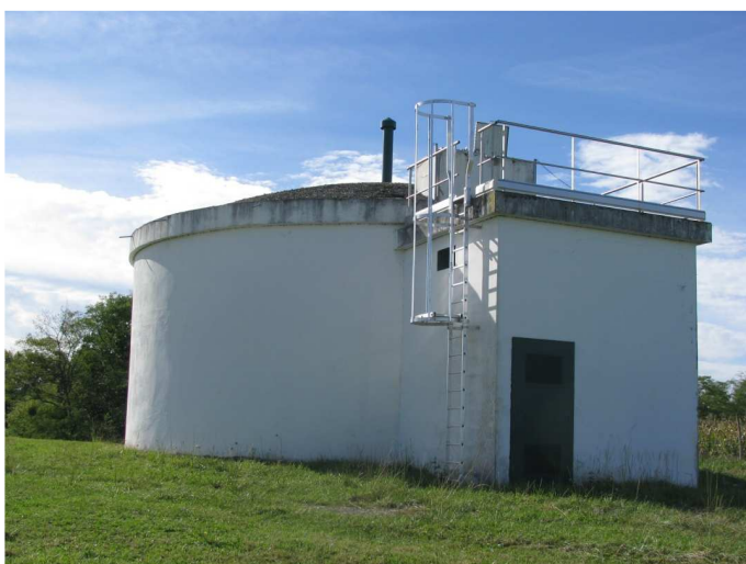
Accès sécurisé au réservoir de Lèbe à Bosdarros.
