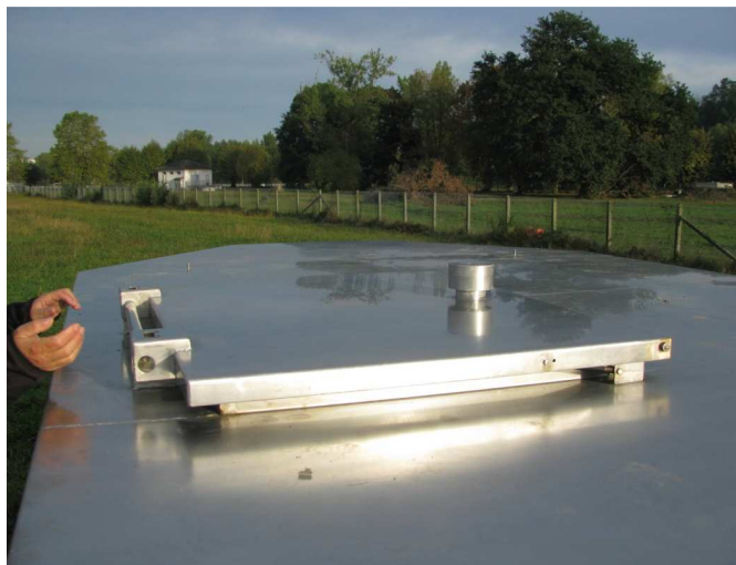
Mise en place du capotage inox sur la tête du puits P18.
