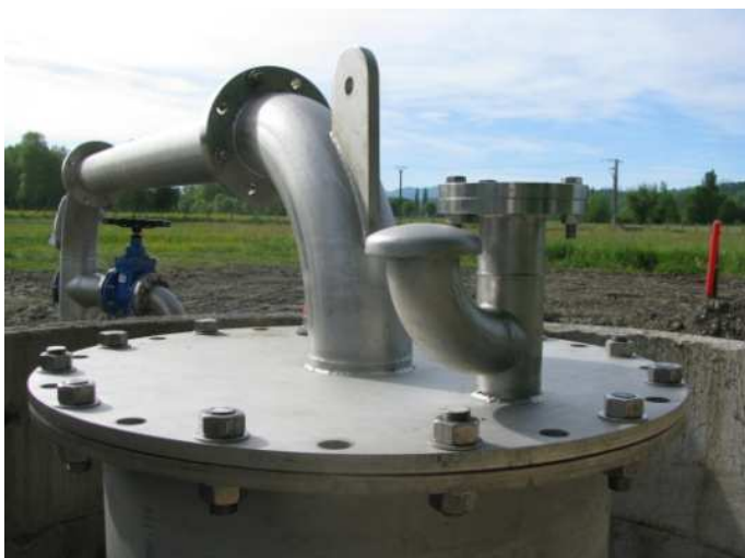
Sécurisation du puits « P9 » et nouvelle hydraulique sur Mazères.
