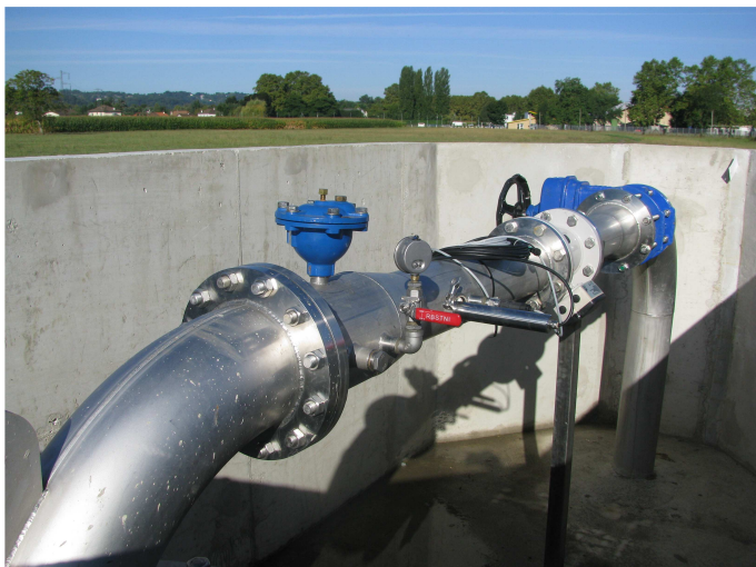
Puits P18 en cours d'instrumentation.
