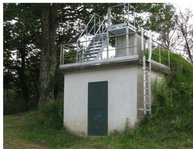
Mise en sécurité de l'accès au réservoir de Sabalot à Gan.
