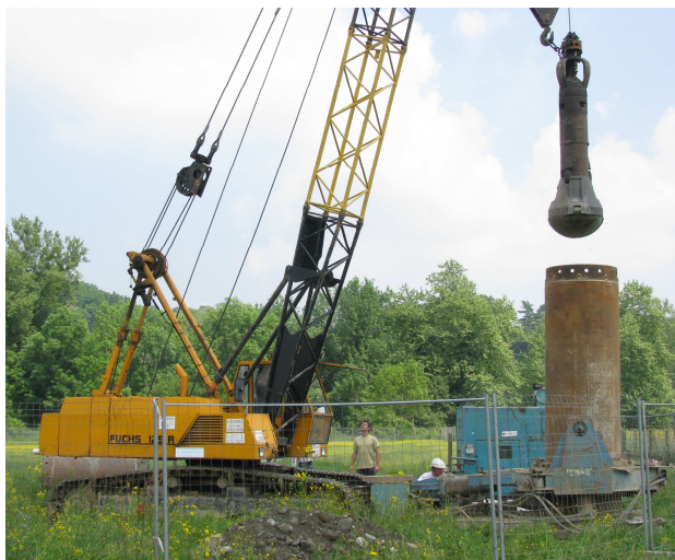
Travaux de foration du puits P18 (à la Bénoto et louvoyeuse).
