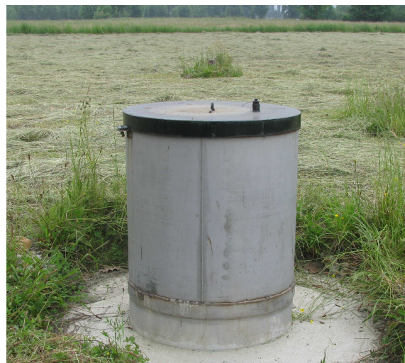
Puits P18 avant équipement et raccordement.
