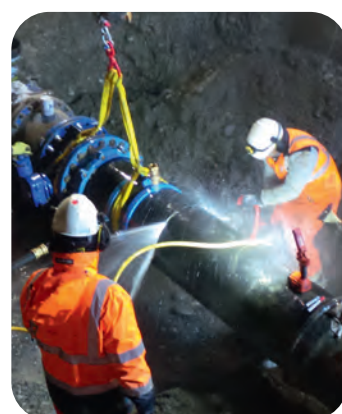
Début de découpe du feeder (00h30), et démontage de la vanne.
