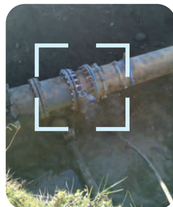
Vanne défectueuse (à gauche), et mise en vidange du feeder (23h).
