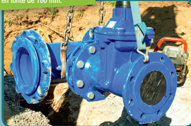
Pose d'un « té » et d'une vanne en fonte de 100 mm.
