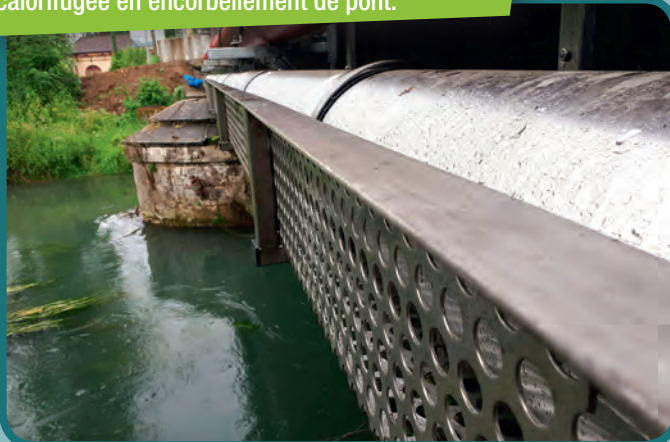
Pose d'une conduite en inox de diamètre 125 mm calorifugée en encorbellement de pont.
