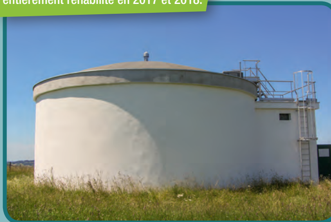
Réservoir de Lèbe de 300 m 3 , entièrement réhabilité en 2017 et 2018.
