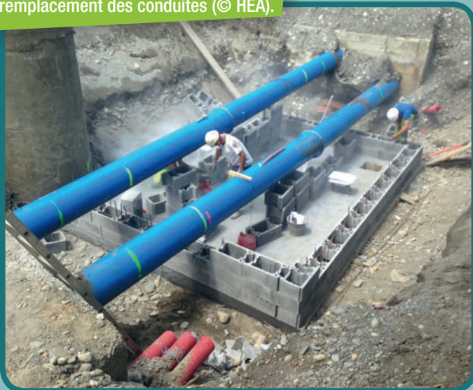
Réalisation du regard avant remplacement des conduites (© HEA).
