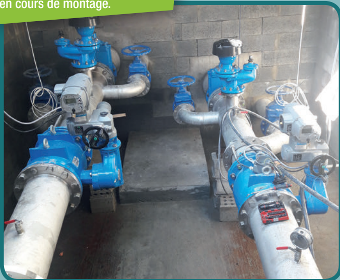
Vannes annulaires motorisées (1 er plan) et ventouses (2 nd plan) en cours de montage.
