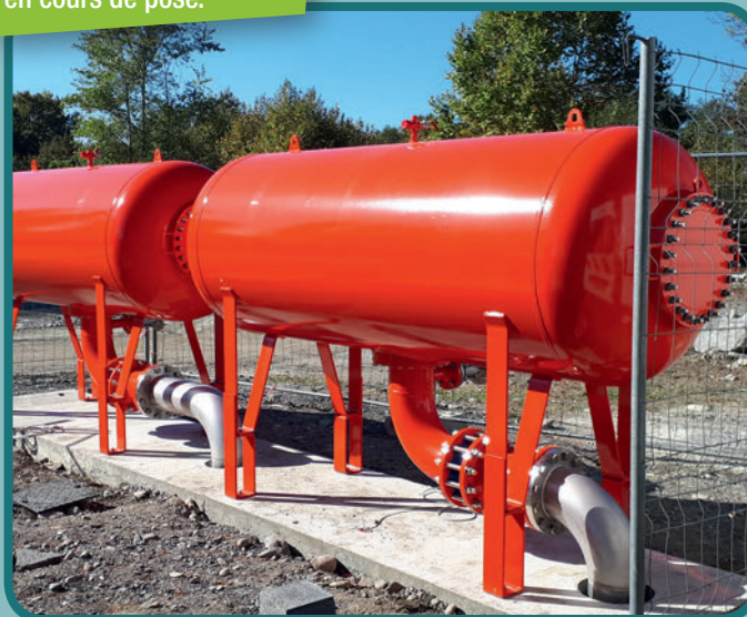
Réservoirs "anti-béliers" en cours de pose.
