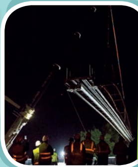
Mise en place de la nouvelle passerelle de Mazères-Bizanos par grutage dans la nuit du 25 au 26 septembre 2017. Photo de P. E. Michel.
