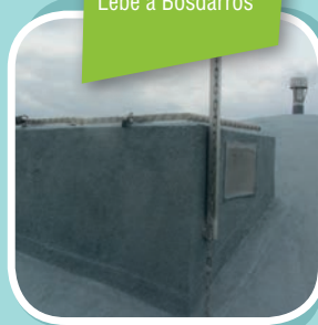
Nouvelle étanchéité extérieure du dôme du réservoir de Lèbe à Bosdarros
