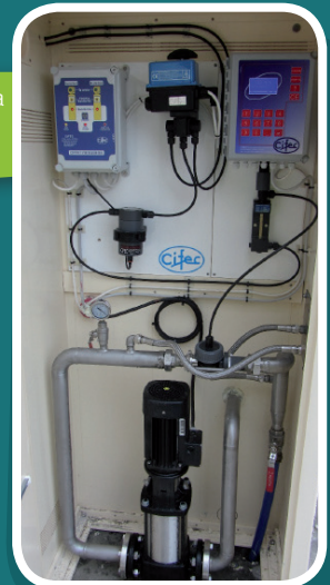
Système de chloration, avec sa pompe de recirculation, situé en amont du champ captant.
