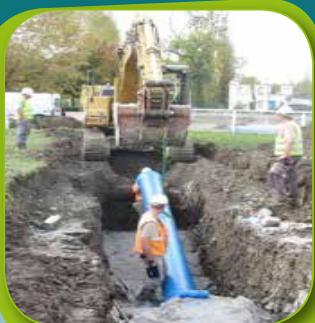
Renouvellement de réseaux en fonte de 400 mm de diamètre au stade d'honneur de Mazères-Lezons
