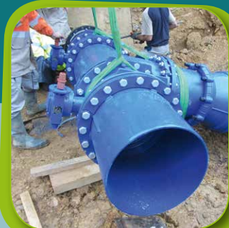
Té de raccordement de la nouvelle bache de 3000 mètres-cubes sur les hauts de Mazères.
