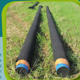
Pose de réseaux en fonte de 100 mm à Bosdarros
