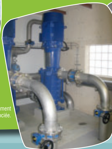
Station de Riant Détail de la reprise des traversées de paroi côté intérieur de la bache.
