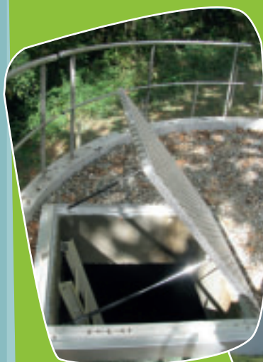
Station de reprise de Lafforgue Trappe d'accès et garde-corps au sommet de la bache.
