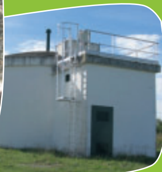
Réservoir de Lèbe - Echelle d'accès et plateforme sécurisées.
