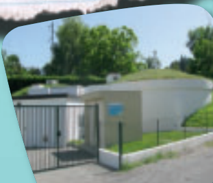
Station de Riant à GAN réhabilitée en totalité fin 2011.
