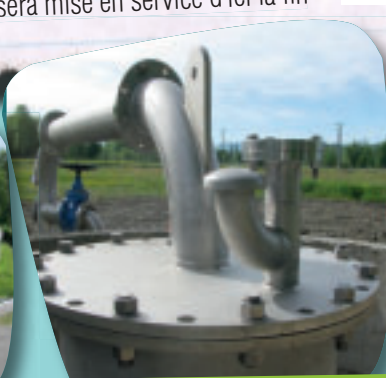
Puits sur « Mazères II » en cours de réhabilitation en 2012.
