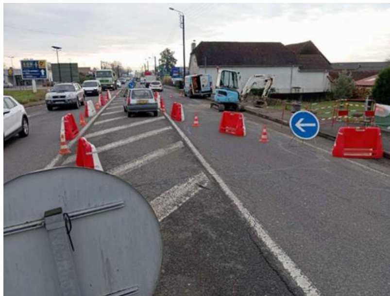
Compteur de sectorisation
