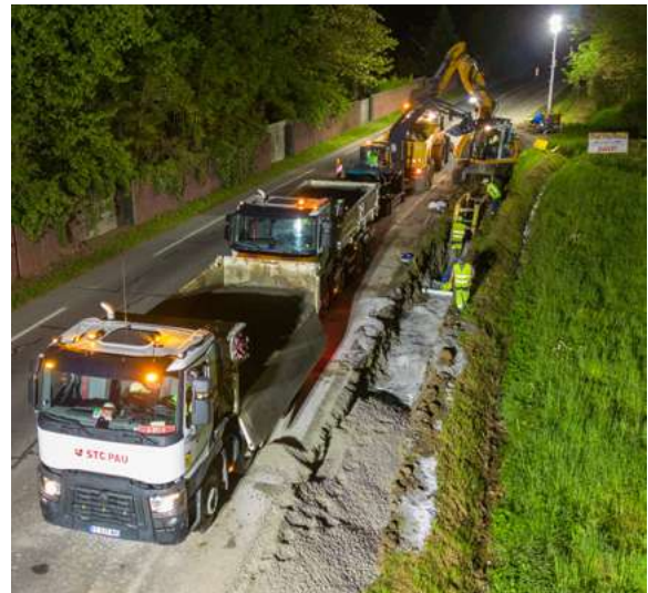
Figure 2 : Travaux de nuit de la nouvelle conduite du « Nid Béarnais »
