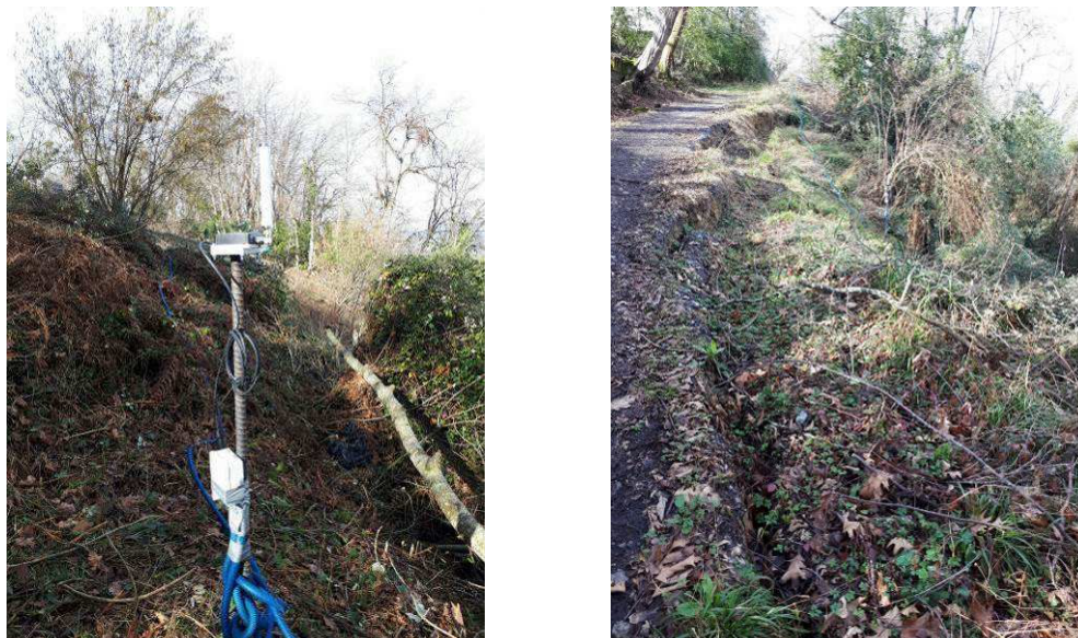
Figure 6 : capteur de surveillance du glissement de terrain, et vue sur la partie haute du glissement côté Monplaisir.
