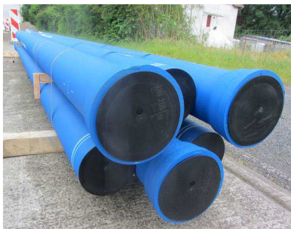
↑ Conduites en fonte de 200 mm avant pose sur Idron.
