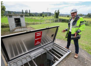
Allande Erreçarret, directeur du SMEP, à l'entrée de l'un des puits de forage. © M. ZIRNELD
