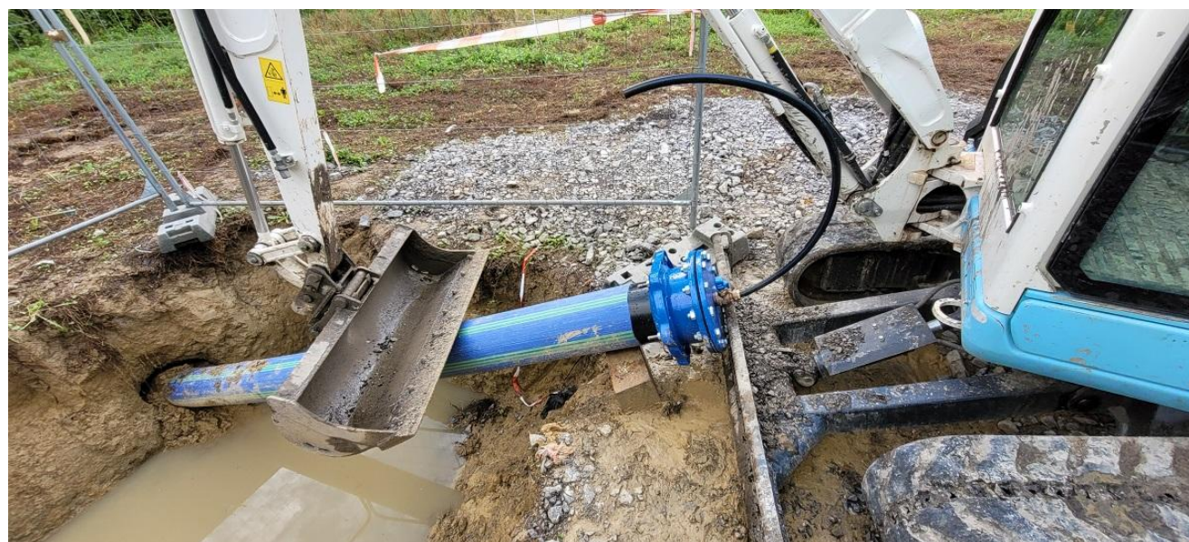
Figure 5 : Sortie de la canalisation posée en forage dirigé sous le Neez
