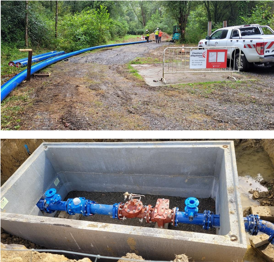
Figure 18 : aperçu de travaux effectués sur les réseaux en 2024.
