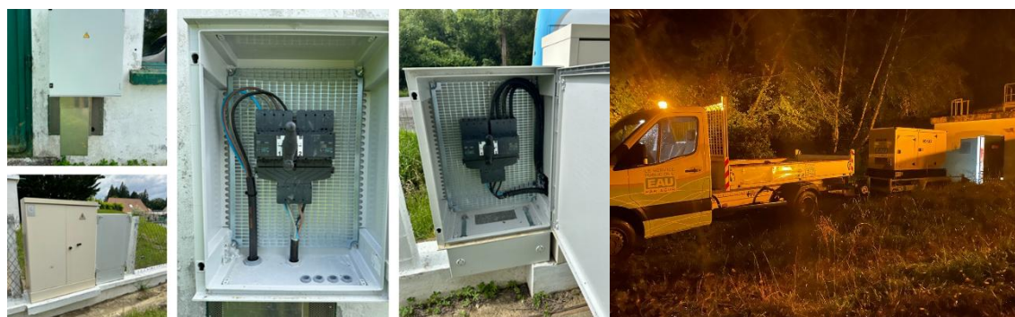
Figure 3 : Inverseurs de source sur Berlanne et Narcastet
