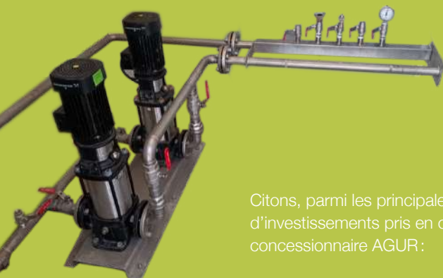
Figure 21 : renouvellement et sécurisation de la chloration principale de Mazères II
